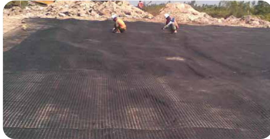
● JALAN AKSES MADHANI - TABANG, KALIMANTAN TIMUR - 2008
