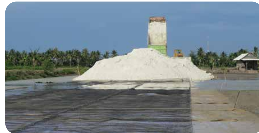
● JALAN AKSES TAMBANG PASIR, LAMPUNG - 2013
