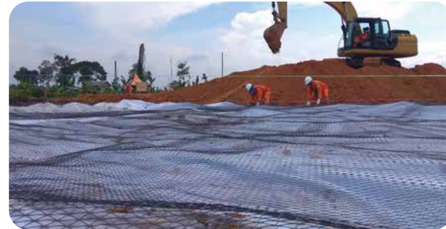
● JALAN HAULING KUALA TUNGKAL, JAMBI - 2017
