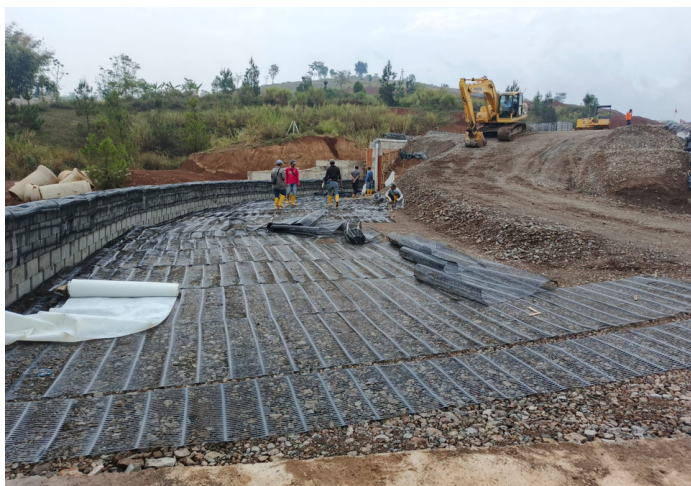
Pekerjaan penggelaran Geogrid
