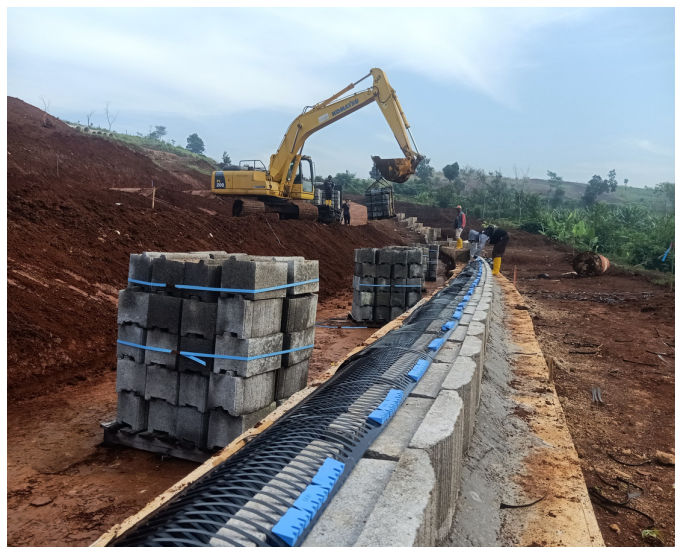
Penyambungan Geogrid dan Modular Blok Beton dengan Connector
