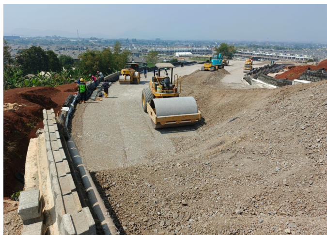
Pekerjaan pemadatan timbunan
