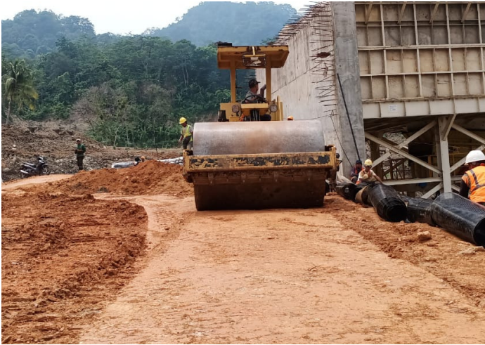
Pekerjaan pemadatan timbunan
