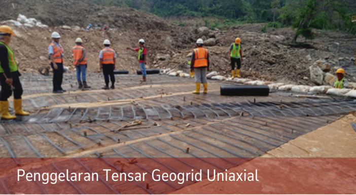
Wraparound Retaining Wall setinggi 12m dengan kemiringan 78°
