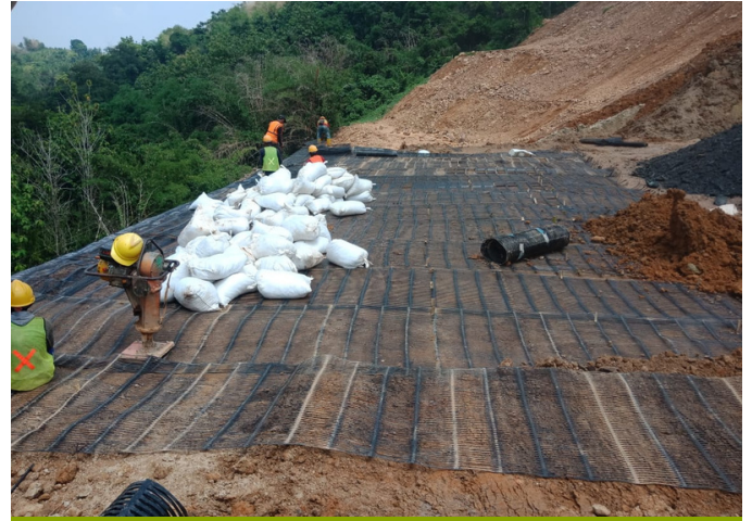
Penggelaran Tensar Geogrid Uniaxial dan pengerjaan sandbag
