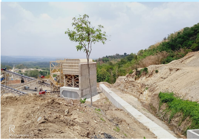
Pekerjaan persiapan, clearing dan menyediakan leveling pad
