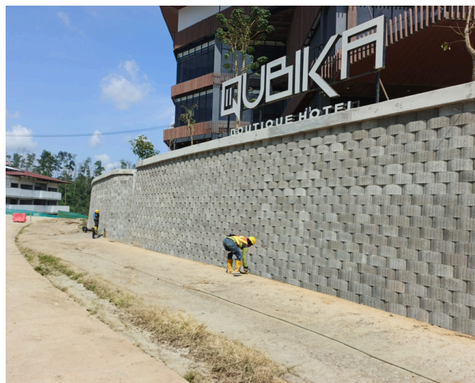
Hasil Akhir Pekerjaan Multiblock Retaining Wall
