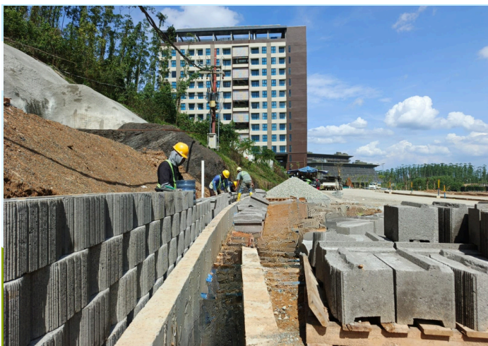
Pemasangan Modular Blok Beton
