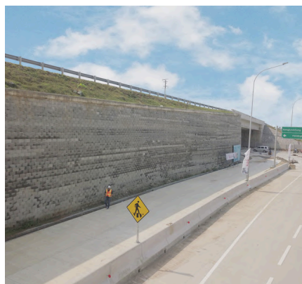
Konstruksi Jalan Tol
