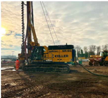
Membangun Platform Kerja yang Stabil di atas Kondisi Tanah Lunak
